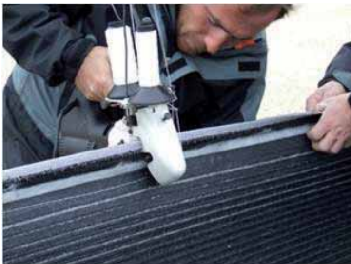
Figura 5. Cosido de una junta de unión de un campo de césped artificial
