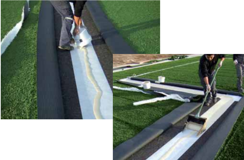
Figura 6. Pegado de una junta de unión de un campo de césped artificial
